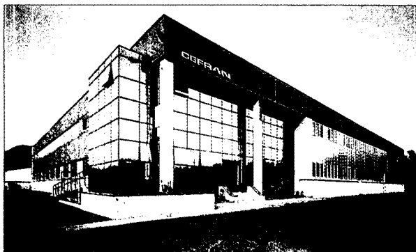
Lo stabilimento che ospita la sede della Gefran
